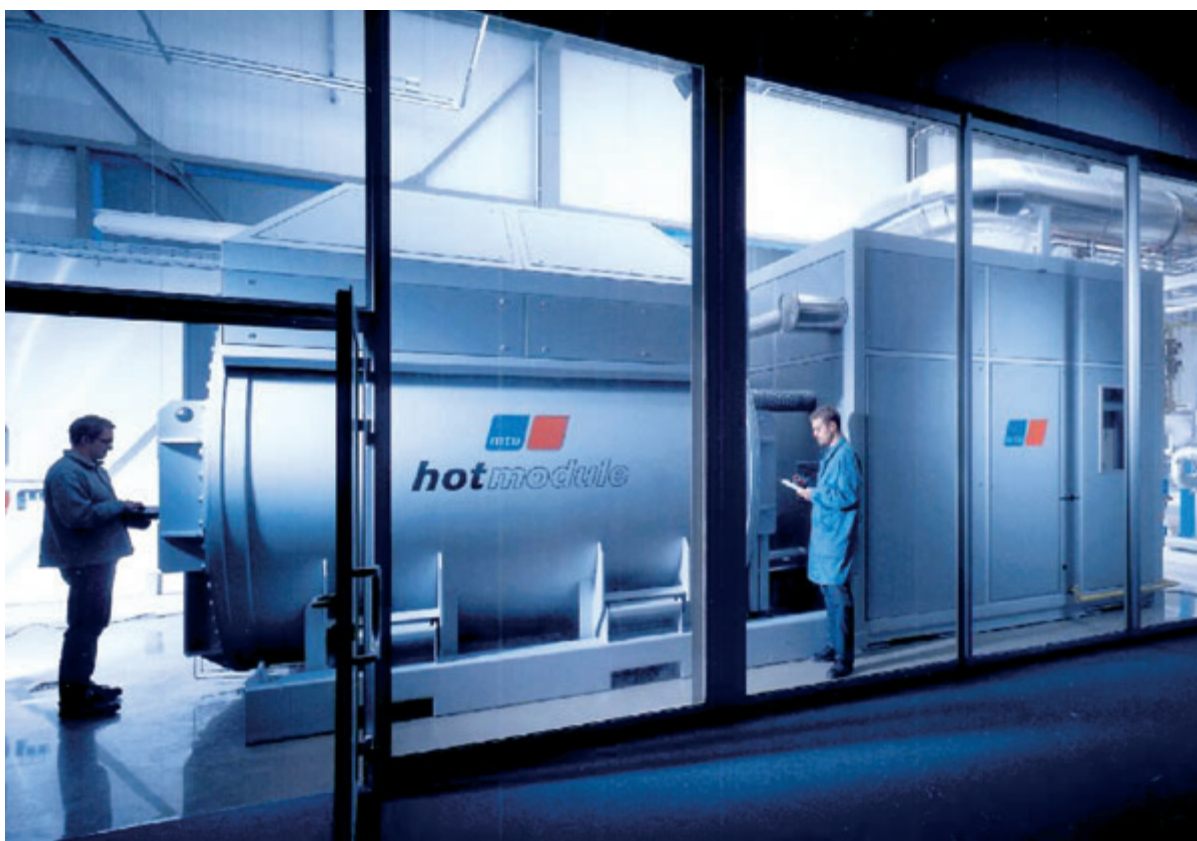
Das Hotmodule der Firma MCFC Solutions GmbH, München, ein 250 kW Schmelzkarbonat-Brennstoffzellensystem, betrieben von der IPF-Heizkraftwerksbetriebsgesellschaft, Magdeburg, am dortigen Universitätskrankenhaus. Eine sichere, effiziente und weitgehend saubere Methode zur Energieerzeugung, die auch nachwachsende Rohstoffe verstromen kann.
